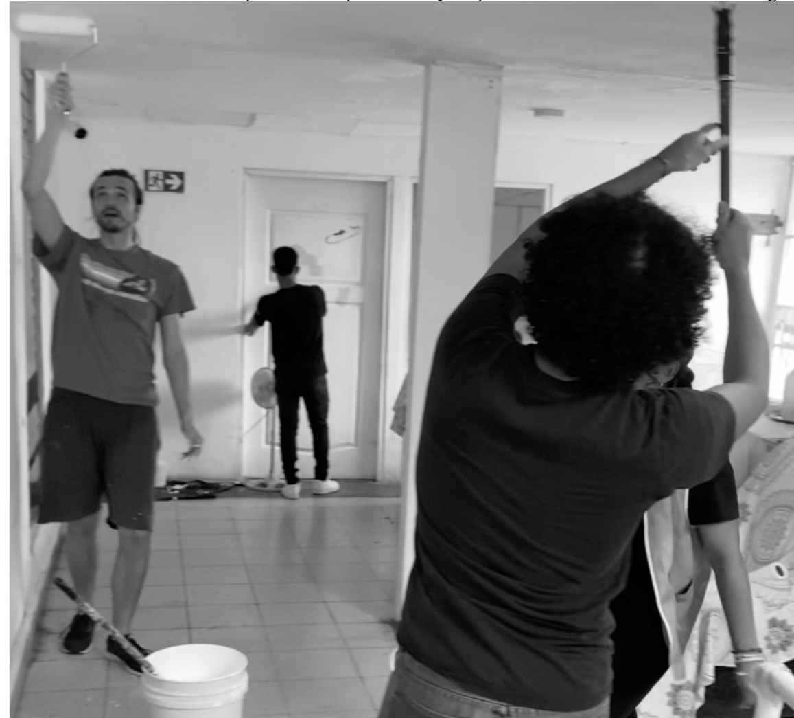
Foto 2: Voluntarios pintando paredes y puertas interiores del albergue.
